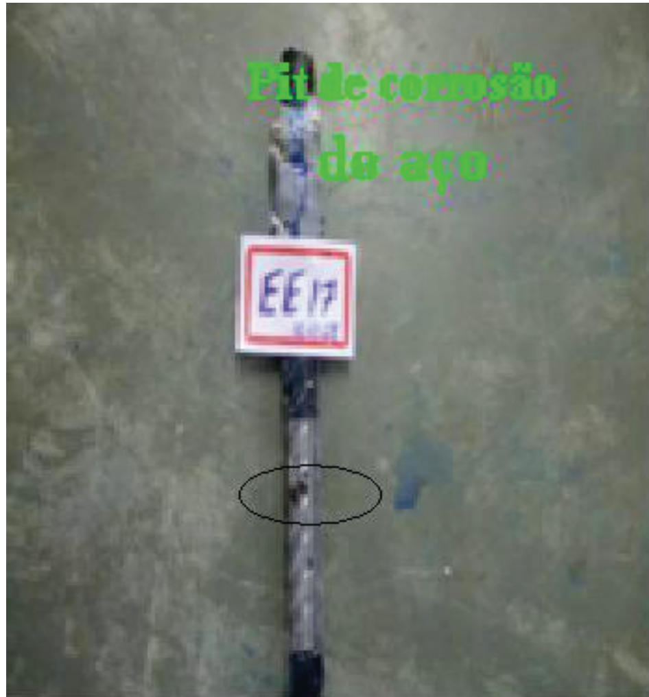
Figura 03- corrosão do aço
