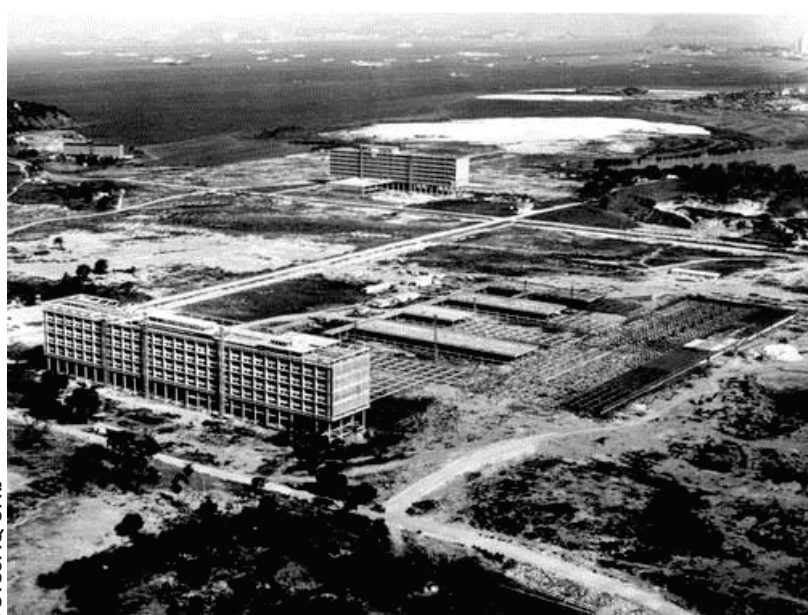
Vista aérea da construção dos prédios da Cidade Universitária, 1954. O prédio principal em destaque abriga, atualmente, o IQ-UFRJ
