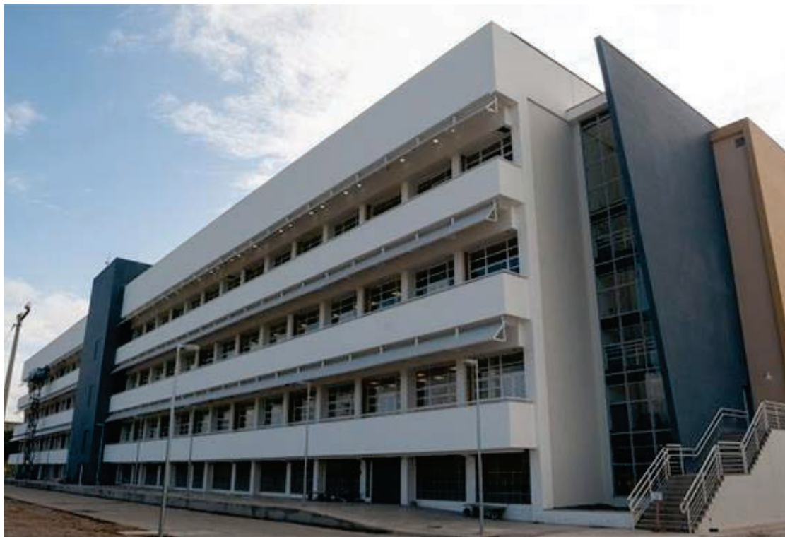
Novas instalações do Ladetec/Polo de Química
