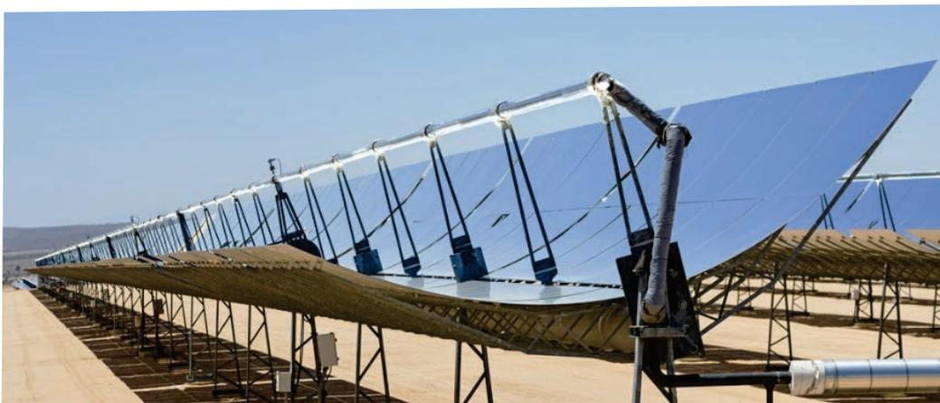
CSP - Concentrador do tipo linear (calha parabólica)
