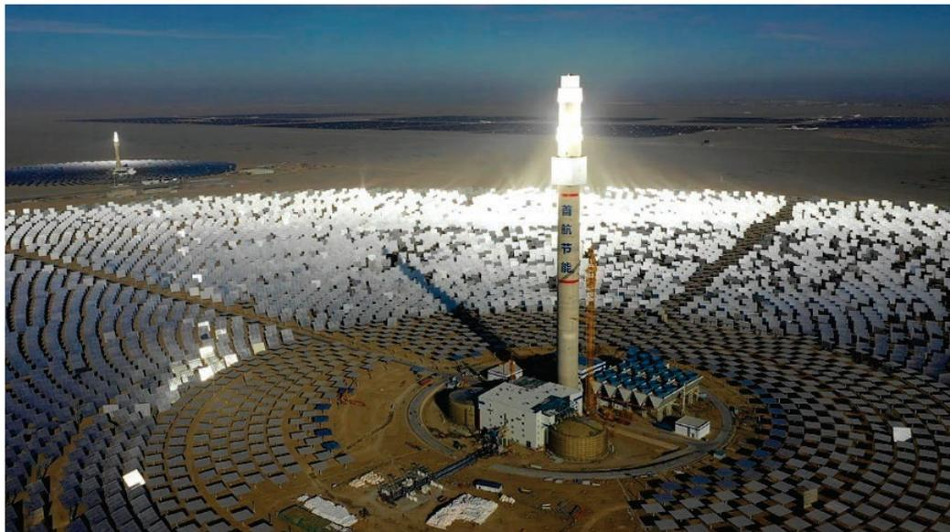
CSP - concentrador do tipo torre central (Heliostato)
