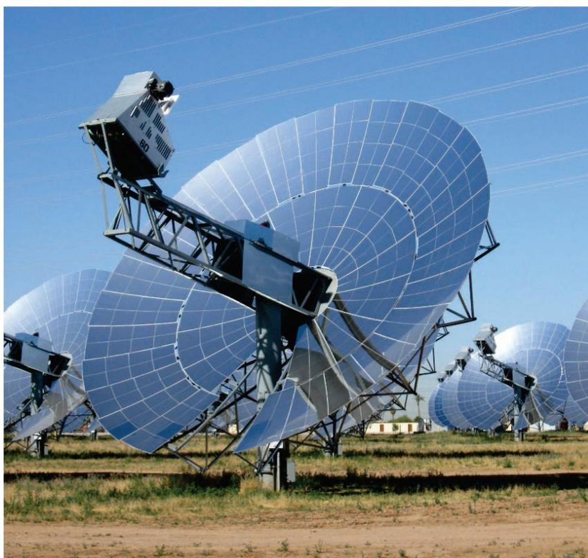
CSP - Concentrador do tipo disco parabólico
