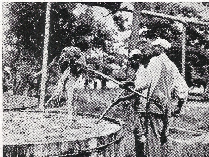
Nesta gravura observa-se a operação de limpeza do sargaço, em grandes tanques, onde é desembraçado de conchas e outros detritos antes do processamento industrial.
