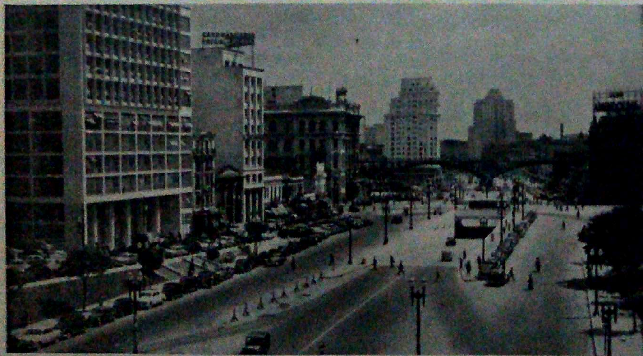
Fig. 3. Parque do Anhangabau, larga via para escoamento de veículos.
