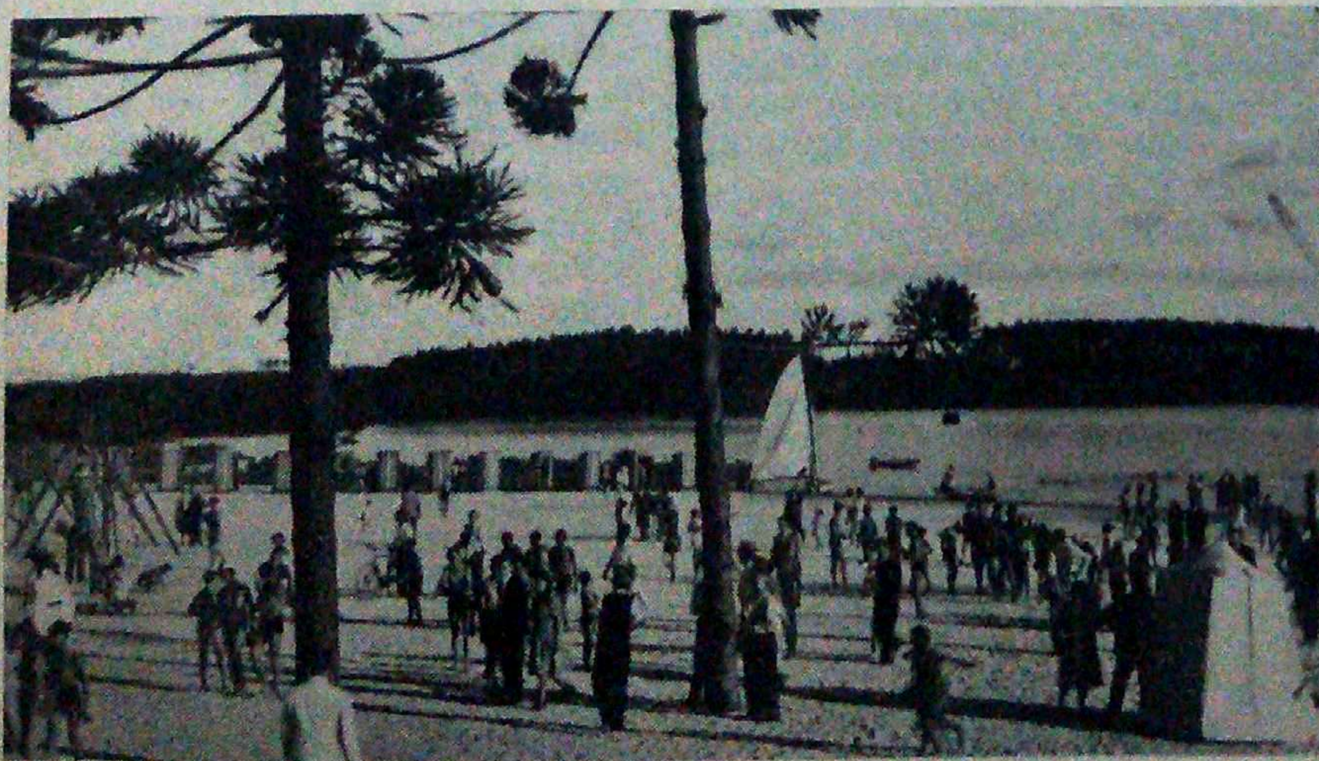
Fig. 5. Aspecto de uma praia de Interlagos. Estas represas fornecem água à usina hidro-elétrica de Cubatão.
