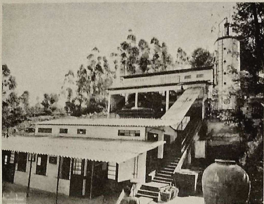
Fig. 3. Unidade de fabricação de ácido oxálico, vendo-se ao fundo a parte onde se encontram os reatores. Nêles se processa a oxidação do açúcar de cana com ácido nítrico, em presença de ácido sulfúrico, para obter o ácido oxálico. No primeiro plano vêem-se as construções destinadas a cristalização do ácido a baixa temperatura ( -15^{\circ}\text{C} ). Os líquidos da reação retornam a 2 torres: numa delas (que aparece na fotografia) é recuperado o ácido nítrico; na outra (que não aparece), menor, recupera-se o ácido sulfúrico.
