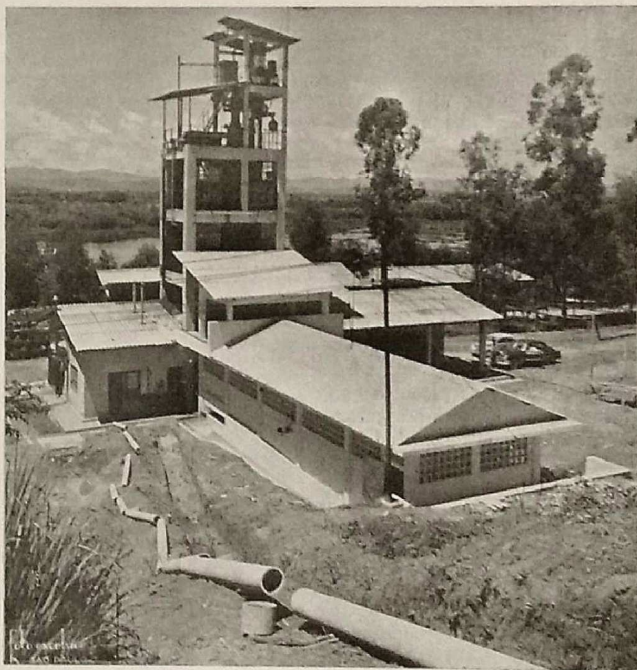
Fig. 4. Unidade de fabricação de peróxido de hidrogênio, vendo-se ao fundo a torre de decomposição do persulfato de amônio em peróxido de hidrogênio e sulfato de amônio. O peróxido é destilado e concentrado em deflagmadores, voltando o sulfato de amônio ao processo de fabricação. No primeiro plano figura o salão, recentemente construído, de células eletrolíticas, que atende ao programa de expansão.
