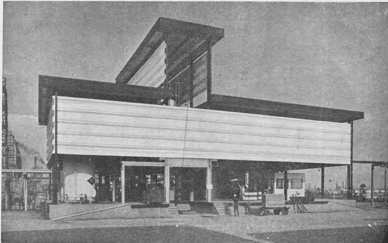
Vista parcial da fábrica de óleos brancos
