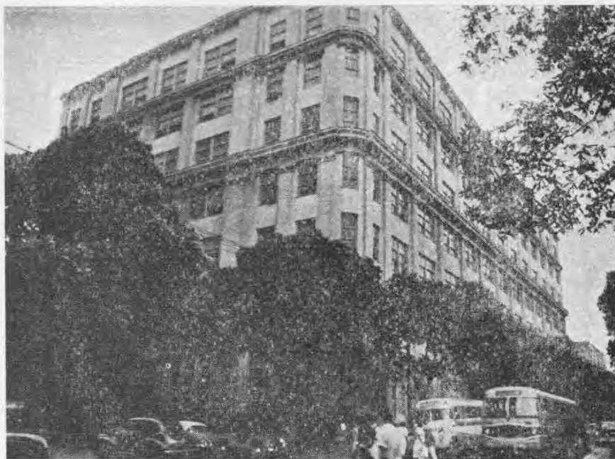
Edifício principal do INT
