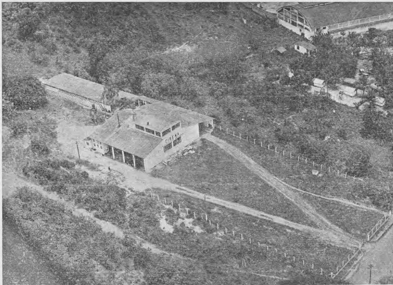
Vista, tomada de avião, da propriedade em que se acha construída a fábrica da CIRENA
