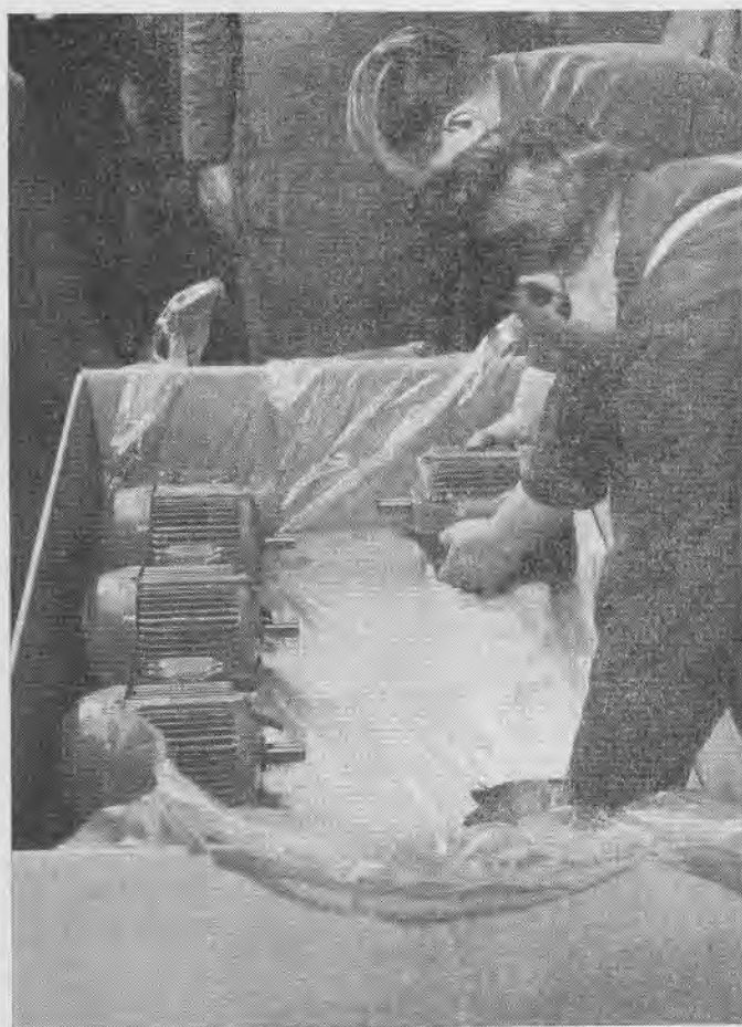
Operação de envolver com fôlhas de plástico os artigos a acondicionar.
