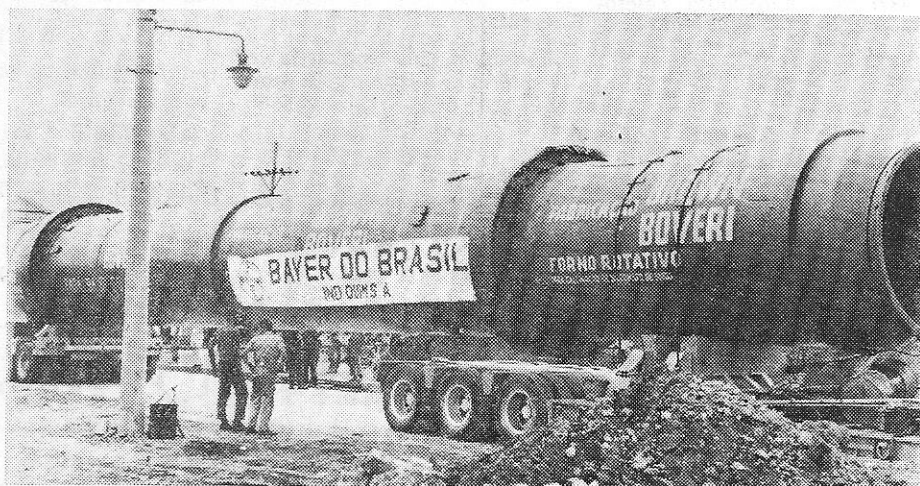
Fotografia que mostra como foi realizado o transporte do grande forno rotativo, construído em São Paulo, pela Indústria Elétrica Brown Boveri S. A.
