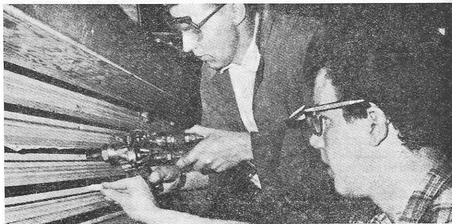
A mistura rígida de uretano pode ser fabricada no próprio local da obra, permitindo assim a aplicação por injeção em cavidades, ou borrifamento em superfícies.
