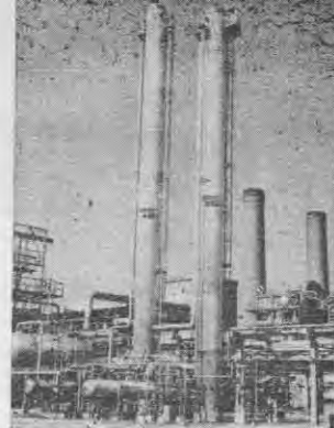
Fábrica de eteno, da Petrobrás, em Cubatão
