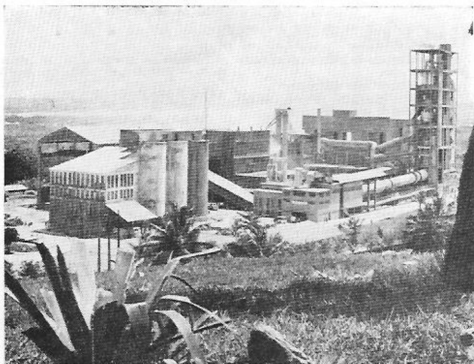
Vista geral da Fábrica de Cimento da Itapessoca Agro-Industrial S. A., em Goiana, Pernambuco. Estas são as novas instalações
