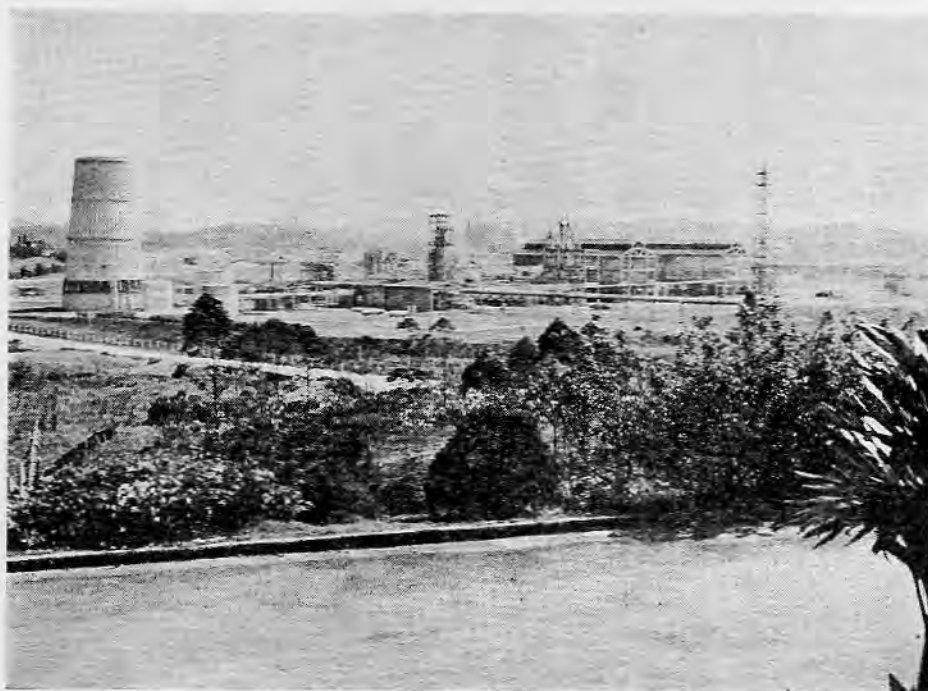
Fábrica da empresa Indústrias Químicas Eletro Cloro- S. A. em Elclor, no município de Santo André, alto da Serra do Mar, km 38 da Estrada de Ferro Santos-Jundiaí
