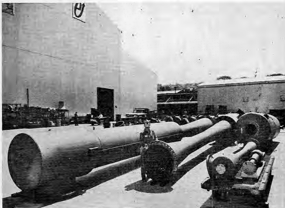
Sistema completo de ejetor de vapor de quatro estágios, com condensador interno, pronto para instalação
