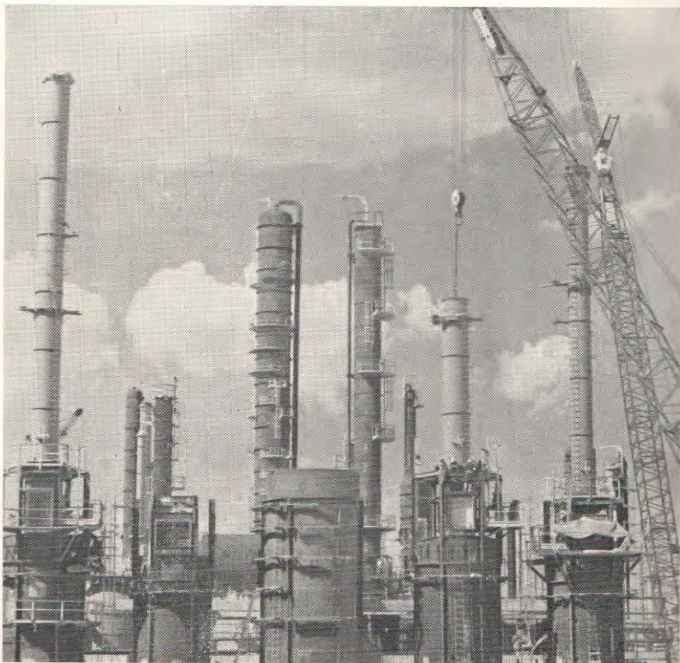
Um aspecto do final de montagem em Capuava do complexo industrial pertencente à Petroquímica União.
