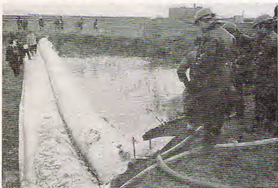
Para esta demonstração dos tubos de «Wolfen» nas condições da prática, a inundação simulada subiu a 60 cm. Entretanto, o sistema de tubos de barragem e de tubos de lastro não deixa passar água.
