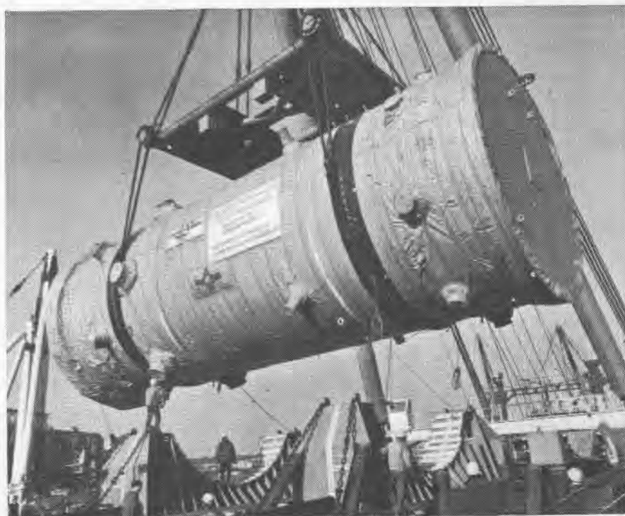
● Vaso de pressão (reator) para a Usina Nuclear nº 1 em Ringhals, Suécia, fabricado pela IHI.
