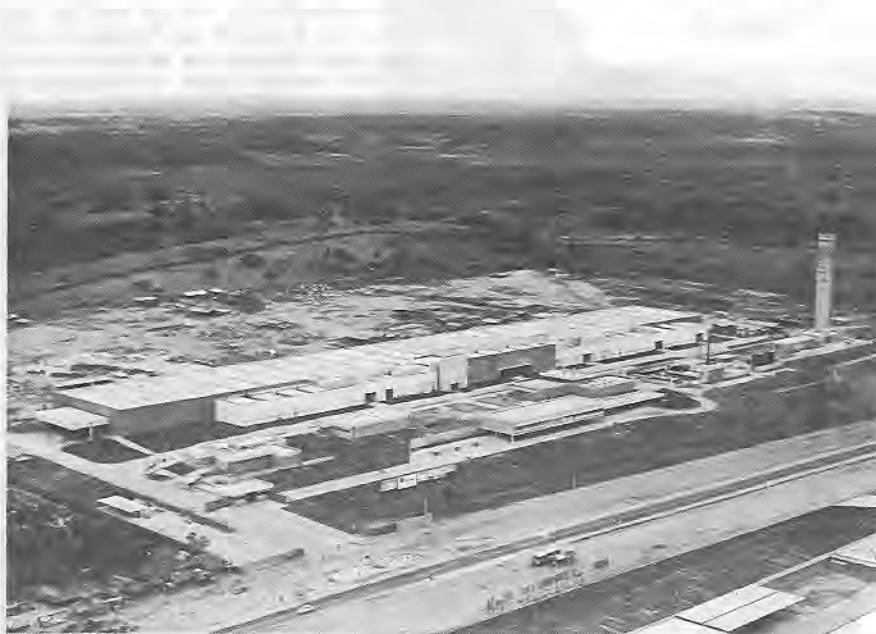
Vista aérea das instalações da nova fábrica.
