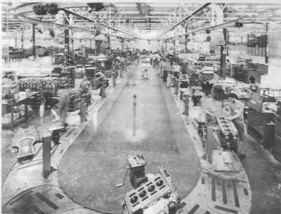
Um aspecto do interior da fábrica de DDA do Brasil, em São José dos Campos.
