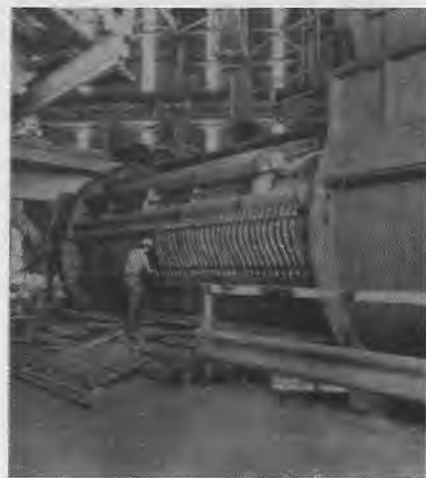
Fig. 1: Vista geral dos estabelecimentos de Overpelt, onde se realiza a extração eletrolítica do zinco.
