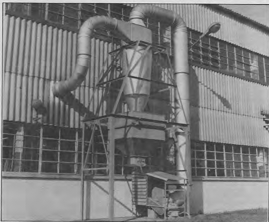
Ciclone; um dos tipos de filtro de ar utilizado pela GMB.
