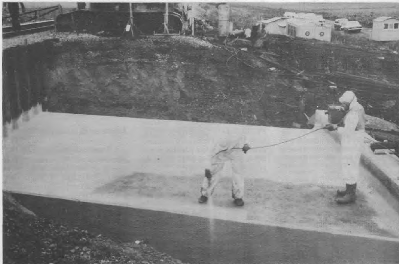
Aplicação da resina de metacrilato em uma de duas partes da nova ponte de concreto de British Railways, perto de Shippea Hill.
