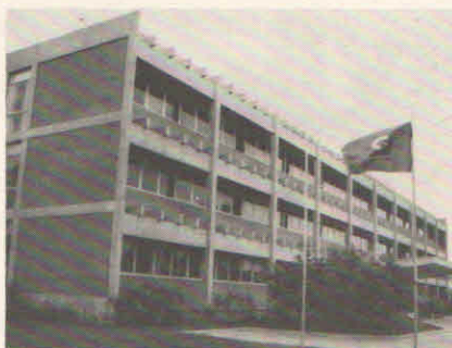
Fachada do Edifício da Administração
