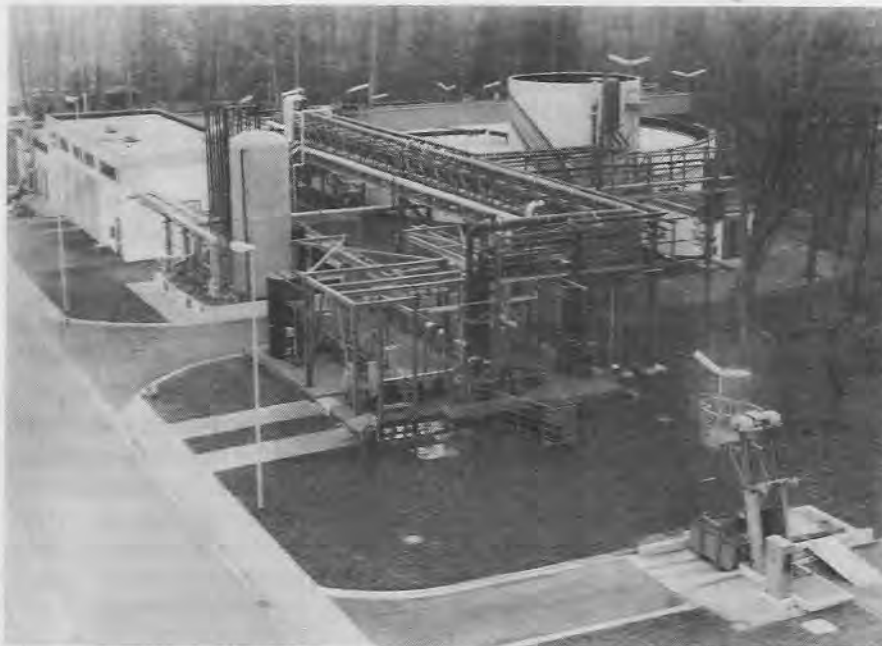
Vista da nova instalação de depuração das águas residuais da sucursal da Degussa em Hanau-Wolfgang.
