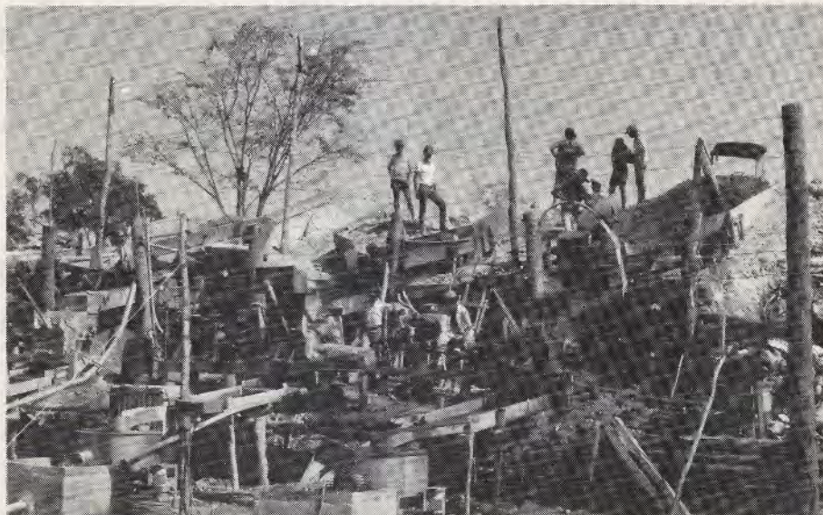
Bicos de jato amontoados em Alta Floresta, MT disputam espaço e separam o ouro de rejeitos
