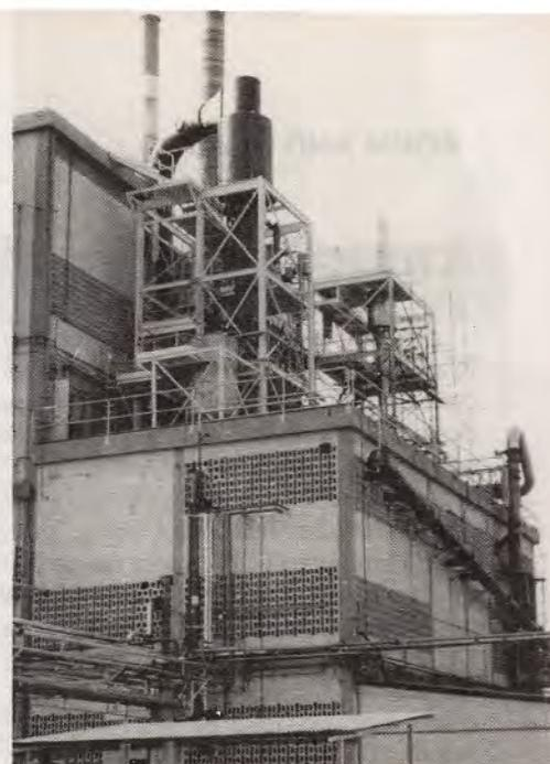
Prédio de produção do Dithane (etileno bis-ditiocarbamato de manganês), vendo-se o sistema de tratamento de efluentes gasosos: lavagem e remoção de particulados
