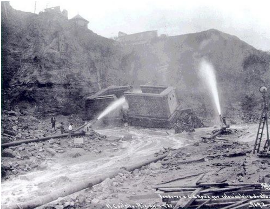
Figura 12 - Desmonte do Morro do Castelo. Foto atribuída a Augusto Malta, 1922.
