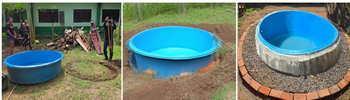
Figura 2 – Construção da Unidade Experimental (viveiro aquático) de Plantas Aquáticas
