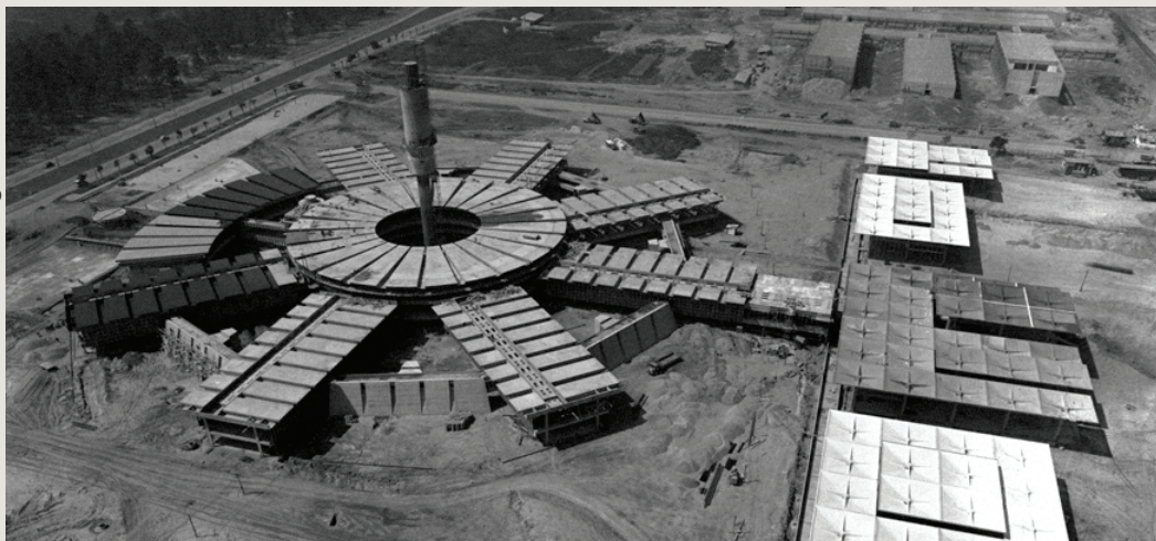
Futura sede do CENPES - Centro de Pesquisas da Petrobrás Leopoldo Américo Miguez de Mello, em construção na Ilha do Fundão, década de 1960
