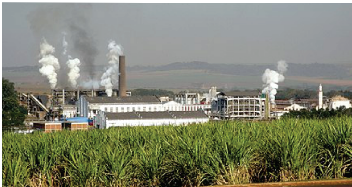
Usina São Martinho - Fábrica de açúcar e etanol em Pradópolis, SP
