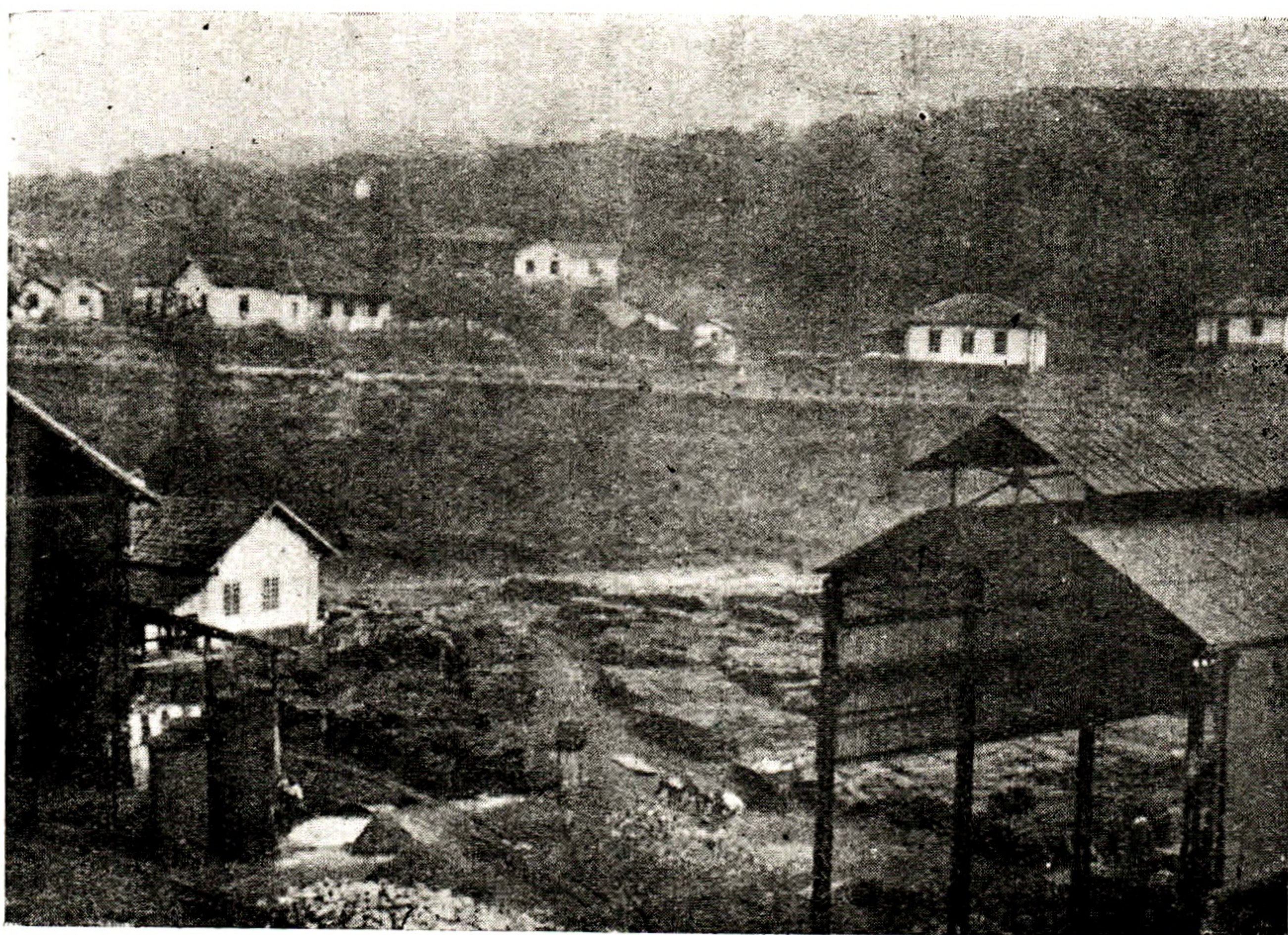
Casa de operarios em Morro Grande
