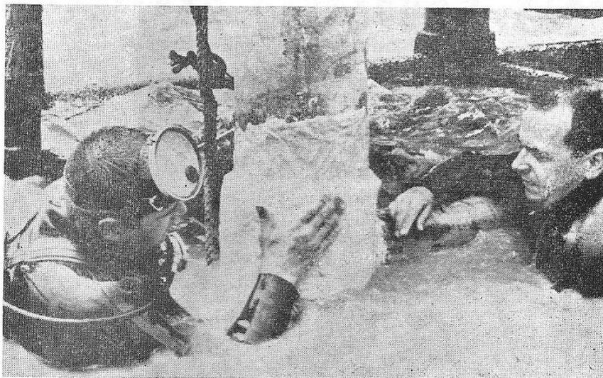
Trabalhadores de manutenção aplicando novo material epoxi a uma plataforma marítima de produção de petróleo, no Golfo do México, a fim de protegê-la contra a corrosão devida à ação da água do mar e do ar. O material foi produzido num laboratório da Shell, nos Estados Unidos da América, e pode-se usar em superfícies metálicas molhadas, e outras.
