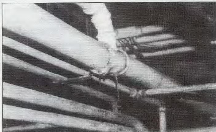
*Figura 1 – Encanamentos danificados de PVC e galvanizado no subsolo do IMA*
